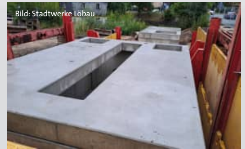
Das Regenüberlaufbauwerk auf der Stauffenbergstraße in der Entstehung.
